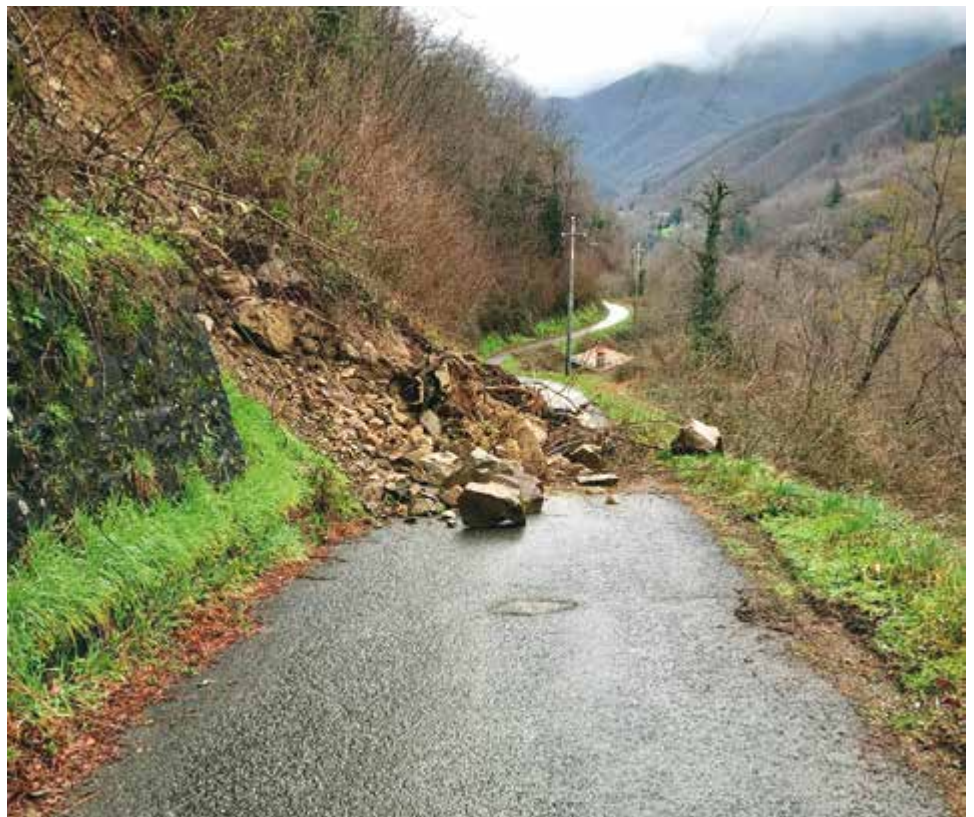
La frana sulla strada comunale Tiglio-Fraia
