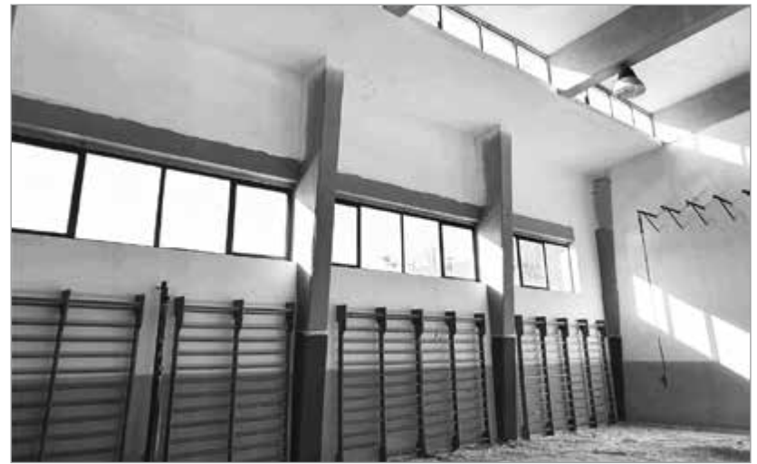
La palestra delle scuole medie dopo i lavori
