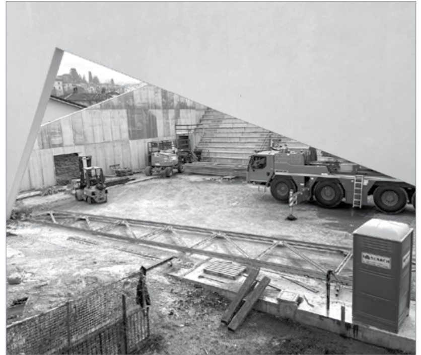
I lavori al palazzetto con le travi di acciaio da montare
