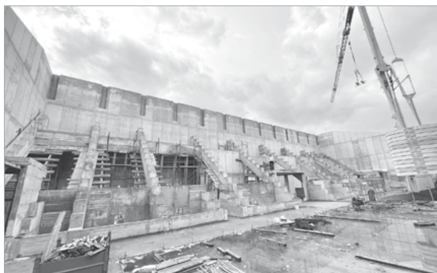
Lavori in corso (dall'alto): alla rocca di Sommocolonia, alla mensa scolastica di Fornaci, al palazzetto dello sport di Barga
