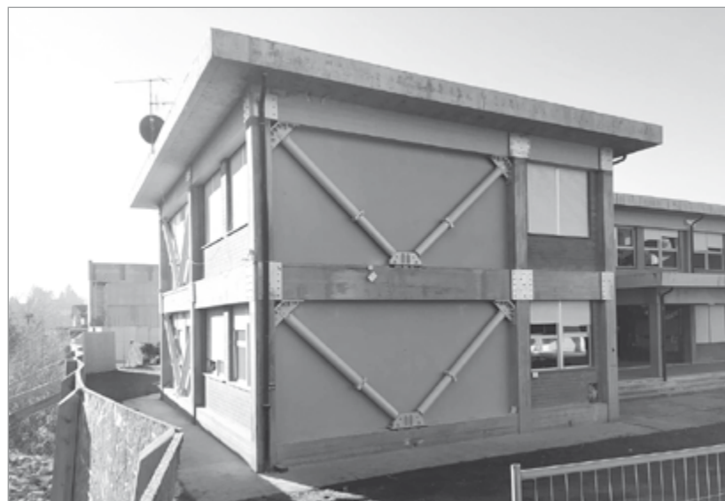
Adeguamento antisismico della Primaria di Barga
