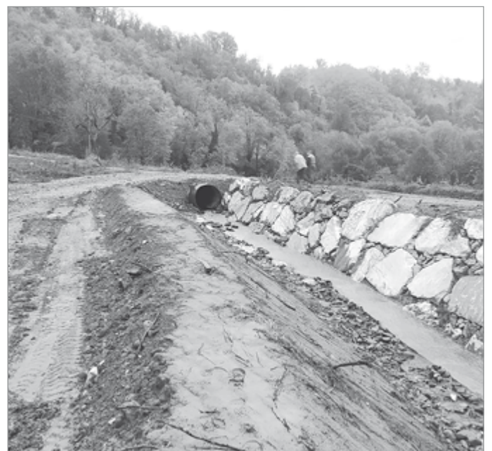
Regimazione delle acque in località Luchi
