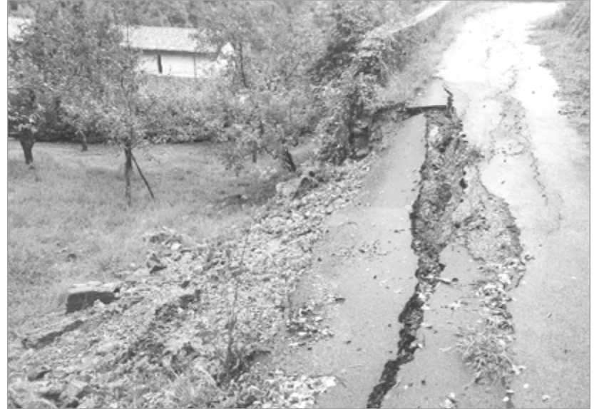
La frana sulla strada di Loppia
