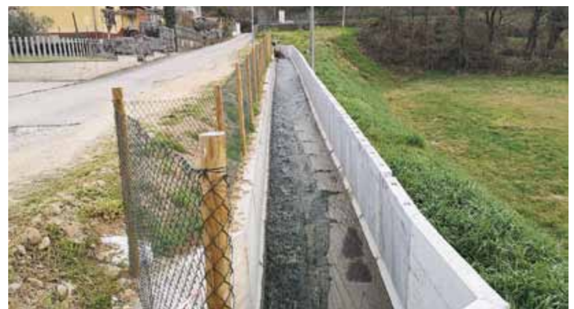
Lavori di regimazione delle acque a Mologno
