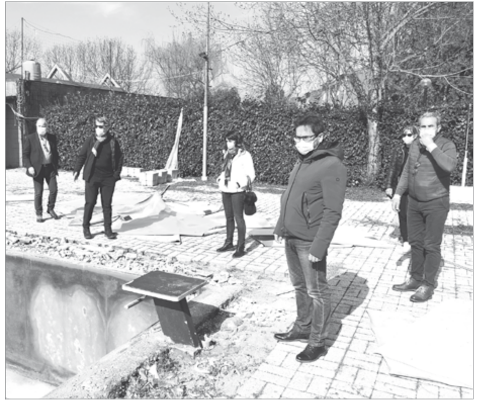
La visita sul cantiere alla presenza dell'assessore regionale Baccelli e del consigliere Regionale Puppa
