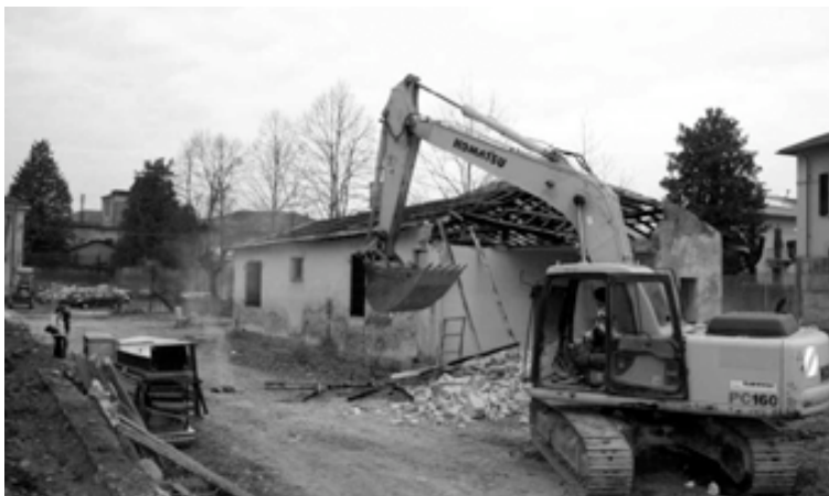
I lavori di demolizione dello stabile
