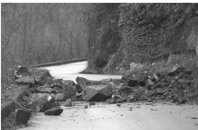
La frana sulla strada di Sommocolonia
