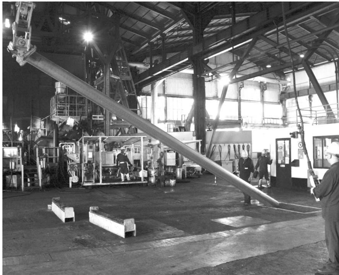
Un'immagine della fonderia rame dello stabilimento KME di Fornaci
