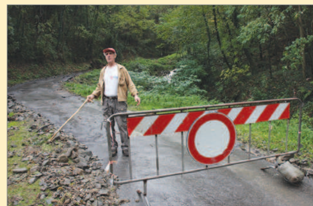
Frane e strade interrotte a causa del maltempo
