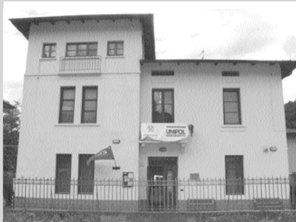
L'edificio che ospita la nuova sede di Unipol di Castelnuovo.
