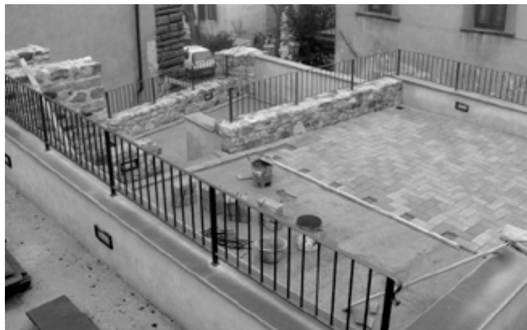
Quasi terminati i lavori a Palazzo Colognori
