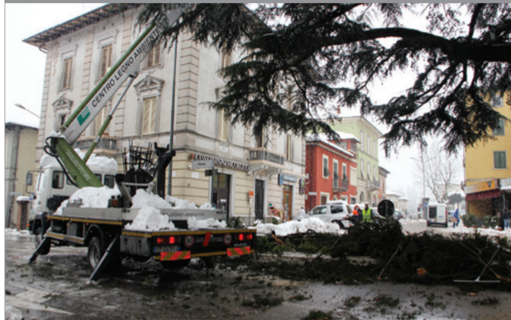
Gli interventi di messa in sicurezza del cedro del Giardino
