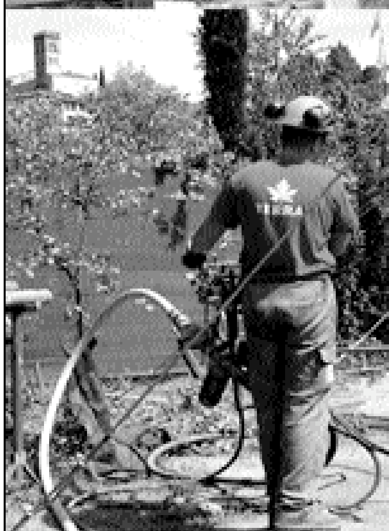
BARGA: cantiere di FONTANAMAGGIO
