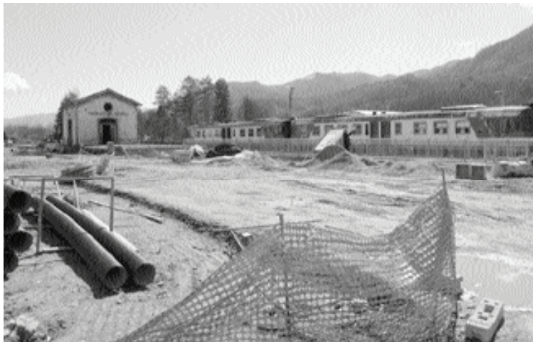
Un'immagine del cantiere dei lavori alla stazione di Fornaci
