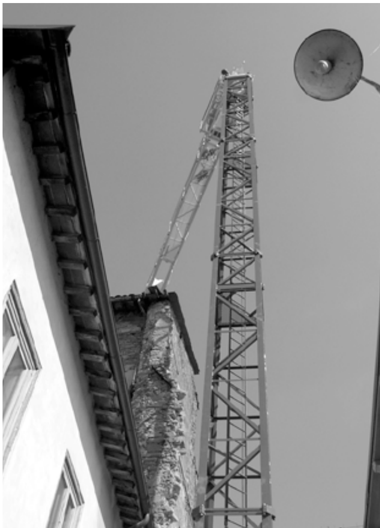
Un'immagine che ritrae parte della gru, ancora in fase di costruzione.
