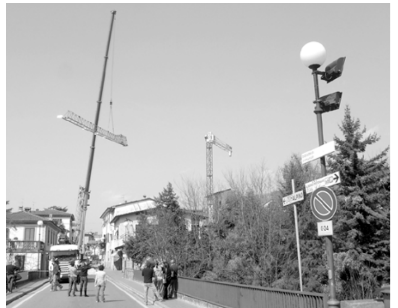
Una fase della complessa operazione di montaggio.
