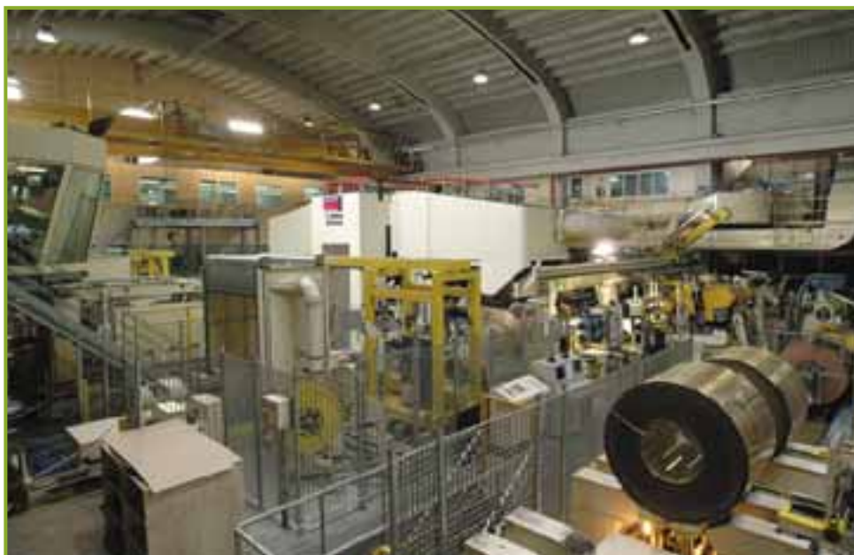
L'impianto di laminazione a freddo Sesto, in grado di laminare 1.000 metri al minuto
